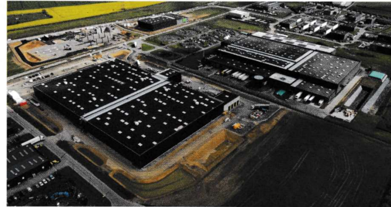
Le 1 er décembre dernier, le Groupe Grand Comptoir a inauguré à Saint-André-sur-Orne son Nouvel Entrepôt Logistique d'une surface de 45 000 m 2 . Ce centre est organisé en trois espaces avec : l'entrepôt historique de 24 000 m 2 consacré aux références mécanisées et comprenant 130 000 emplacements ; une cellule de 3 000 m 2 entièrement automatisée et équipée de 52 robots Knapp de dernière génération qui permet de gérer 43 000 emplacements – deux allées supplémentaires de racks seront ajoutées d'ici 2025 pour porter la capacité à 96 000 emplacements ; et un bâtiment de 18 000 m 2 dédié aux références non mécanisées et volumineuses. Ces bâtiments sont pourvus d'une centrale photovoltaïque et d'un système de chauffage par pompe à chaleur destinés à l'autoconsommation énergétique du site.
