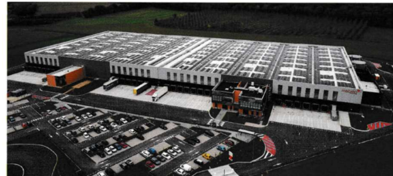
La logistique est un enjeu important de la distribution BtoB, car les stocks représentent des montants importants dans la composante des BFR. Ici la plate-forme Mabéo Industries de Montagnat (01).
